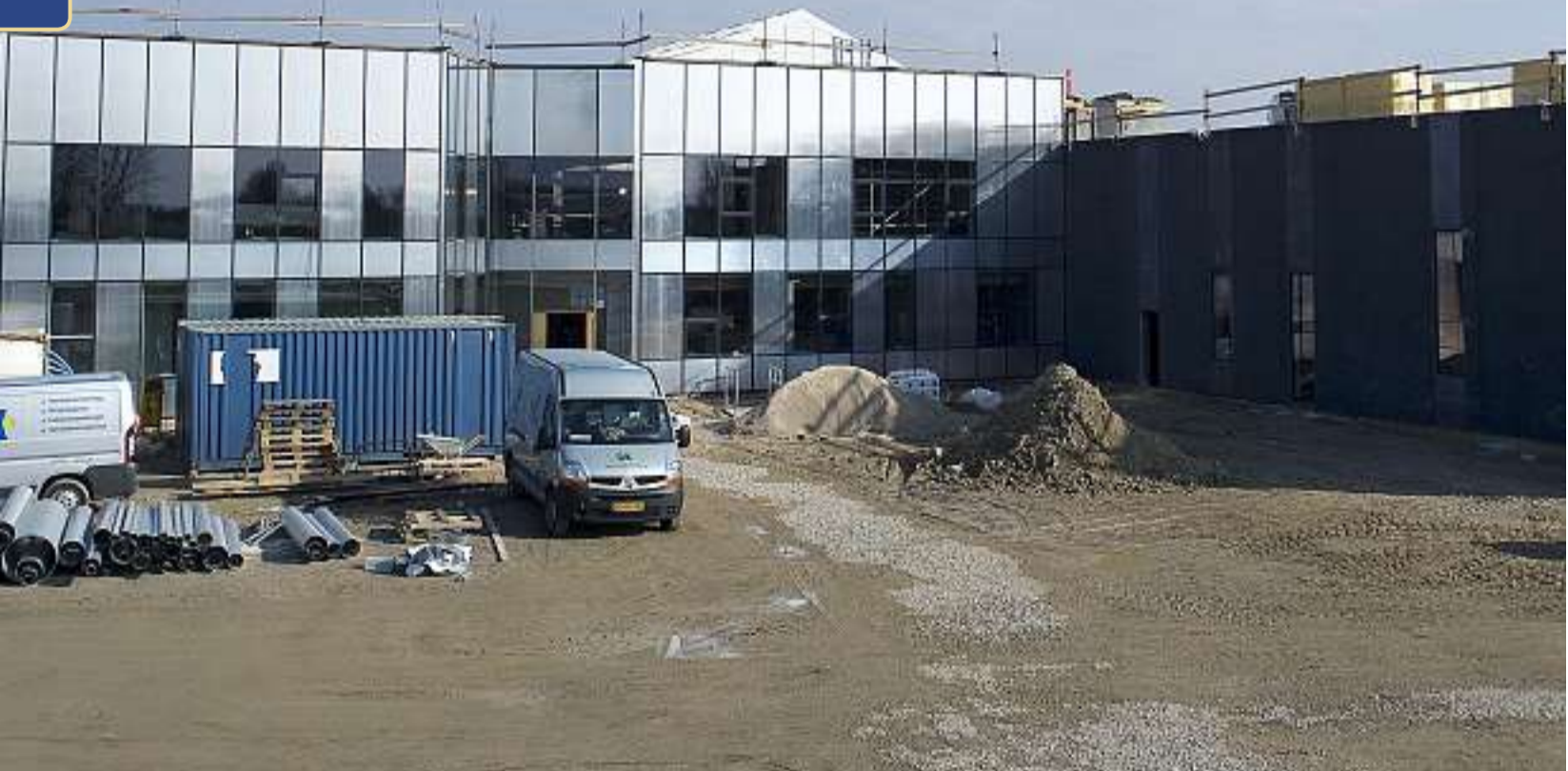
Hovedbygningen i to etager er skubbet ind i mellem produktionshallerne i Jorgensen Engineerings nye domicil.
